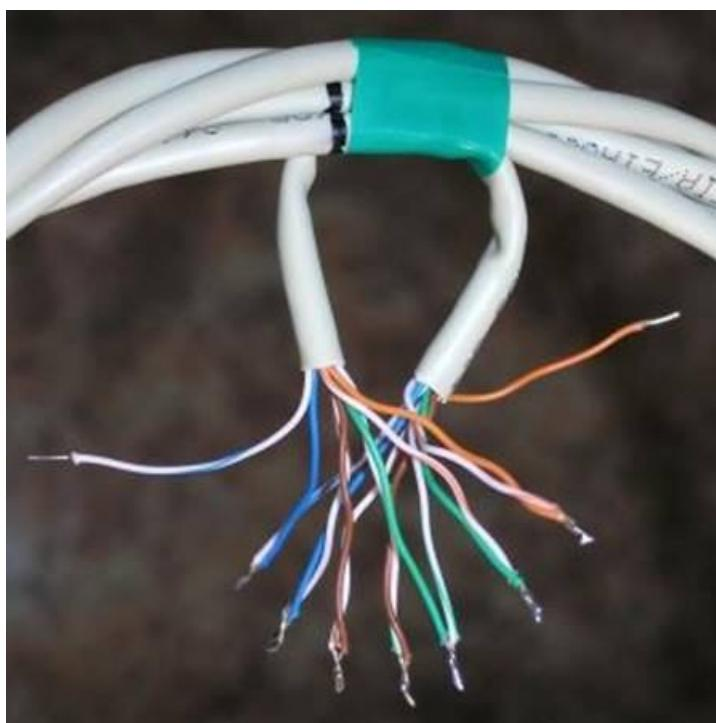
Места спайки проводов удобнее всего заизолировать отрезками тонкой трубки термоусадки, как это показано на фото. Трубка нагревается монтажным феном или просто над пламенем свечи или зажигалки, после чего она плотно обтягивает место пайки и прочно на нем удерживается.
